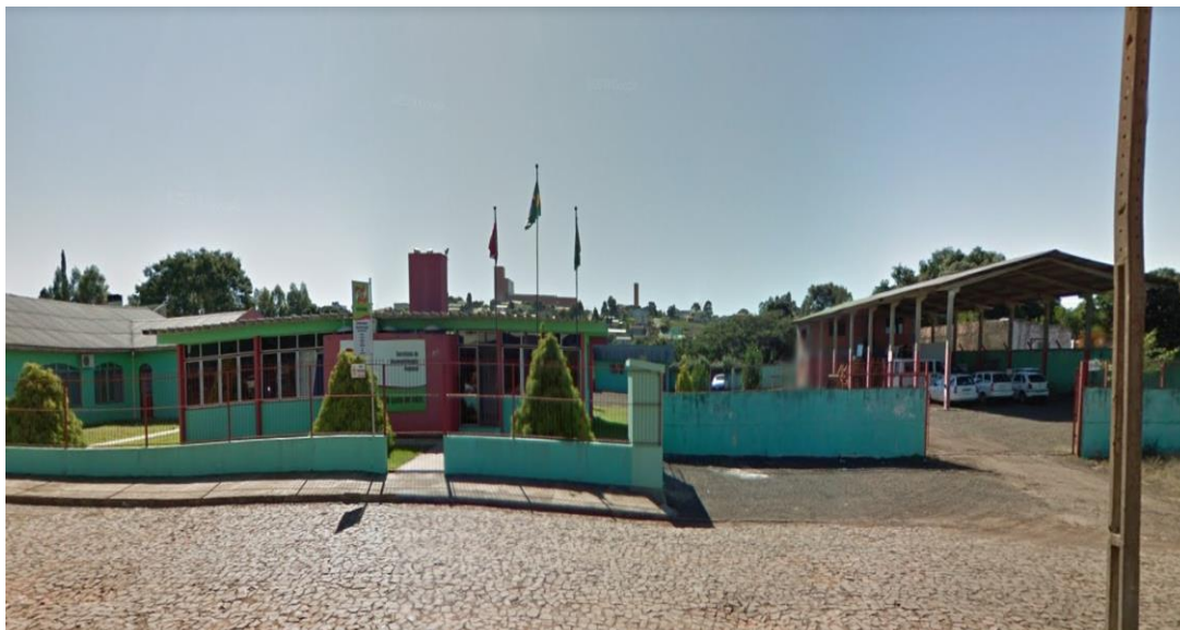
Figura 24 – Levantamento fotográfico das edificações existentes.
