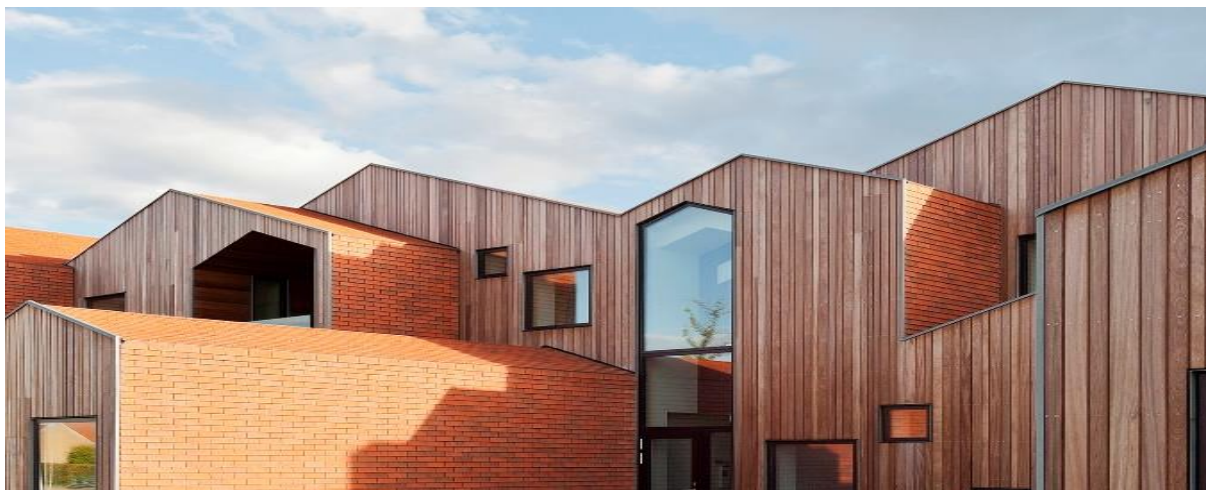
Figura 8 - Predominância de madeira e azulejos
