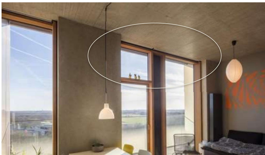
Figura 25 - Imagem indica ausência de vigas.
