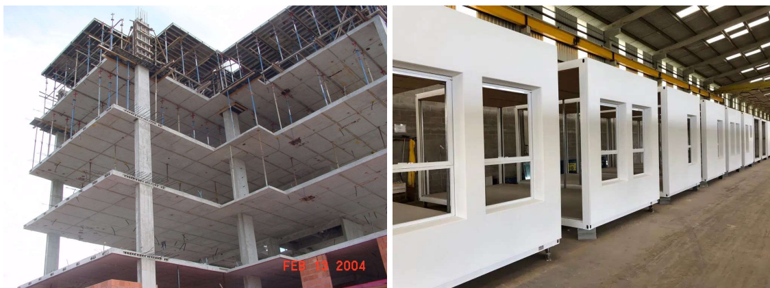
Figura 72 – Exemplo de estrutura em concreto protendido e módulos em steel frame
