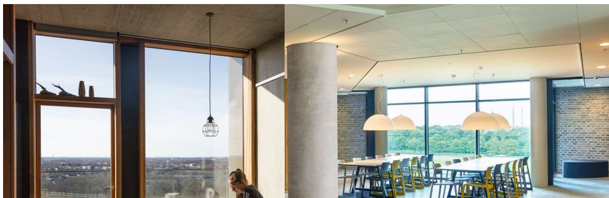
Figura 32 - Imagem 1: Visualização da laje com ausência de viga. Imagem 2: visualização da coluna em concreto armado e logo ao fundo o fechamento em alvenaria estrutural.
