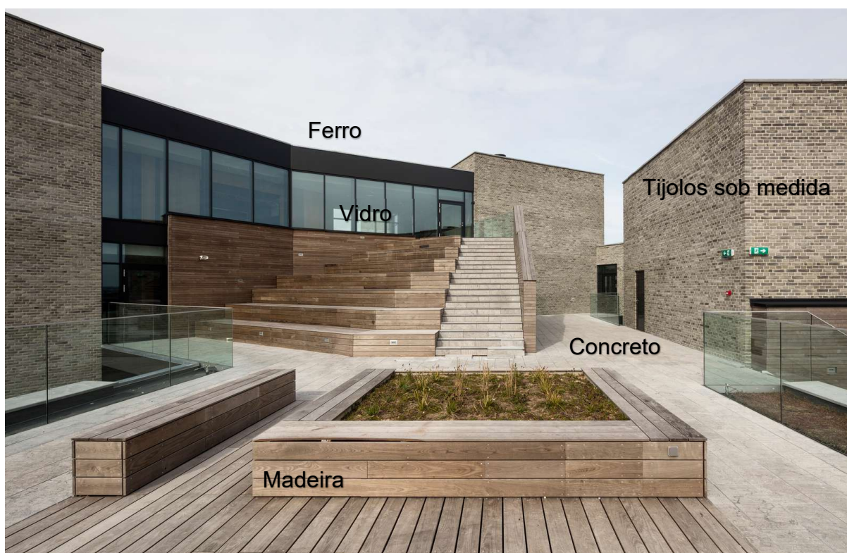
Figura 33 - Imagem do terraço do edifício – identificação dos materiais.
