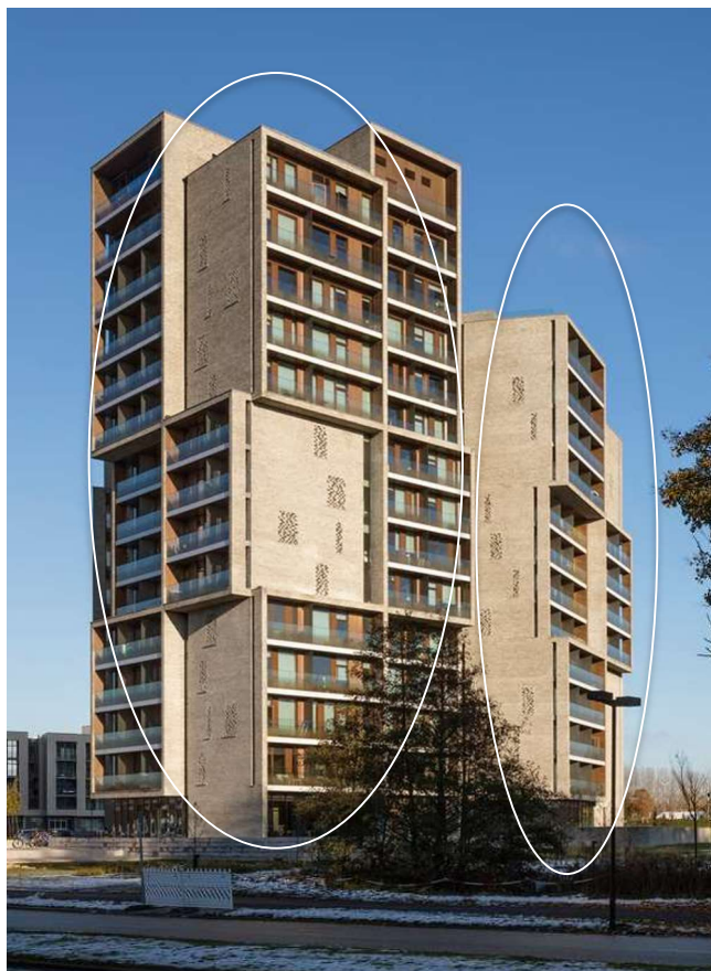
Figura 38 – Foto da edificação, com a evidência dos blocos compositivos iniciais.
