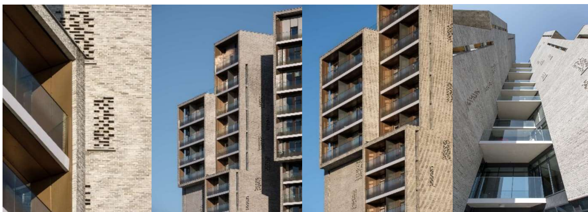
Figura 37 – Imagens de detalhes da fachada em destaque.
