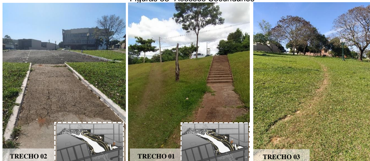
Figuras 53- Acessos Secundários
