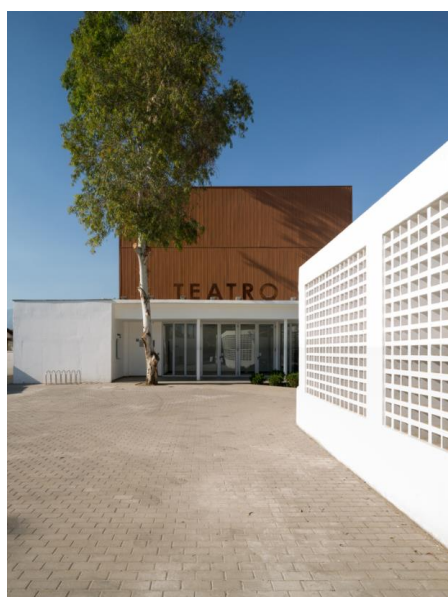
Figura 22 - Bloco onde localiza-se o auditório
