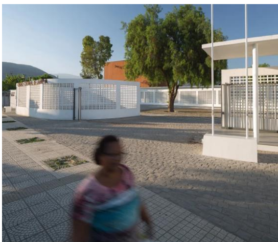
Figura 16 - Fachada do edifício
