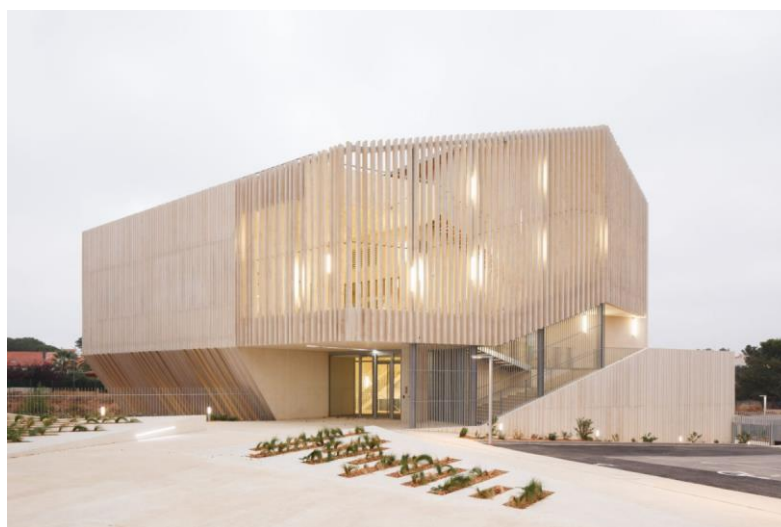
Figura 1 - Fachada do Centro Cultural Espaço Guy Moquet
