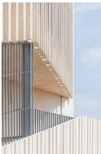
Figura 14 - Vista do edifício
