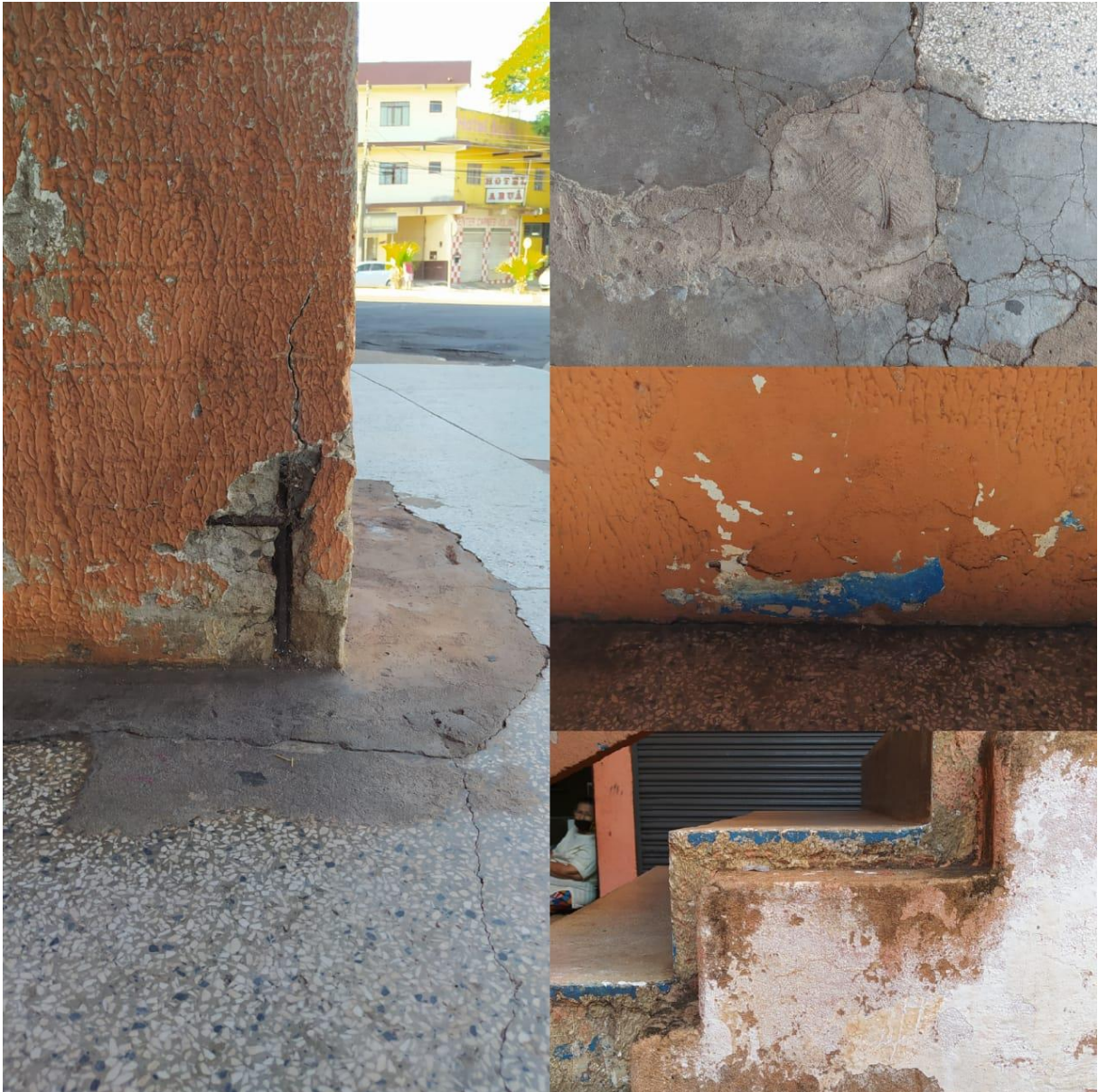
Figura 22 - Situação atual do edifício
