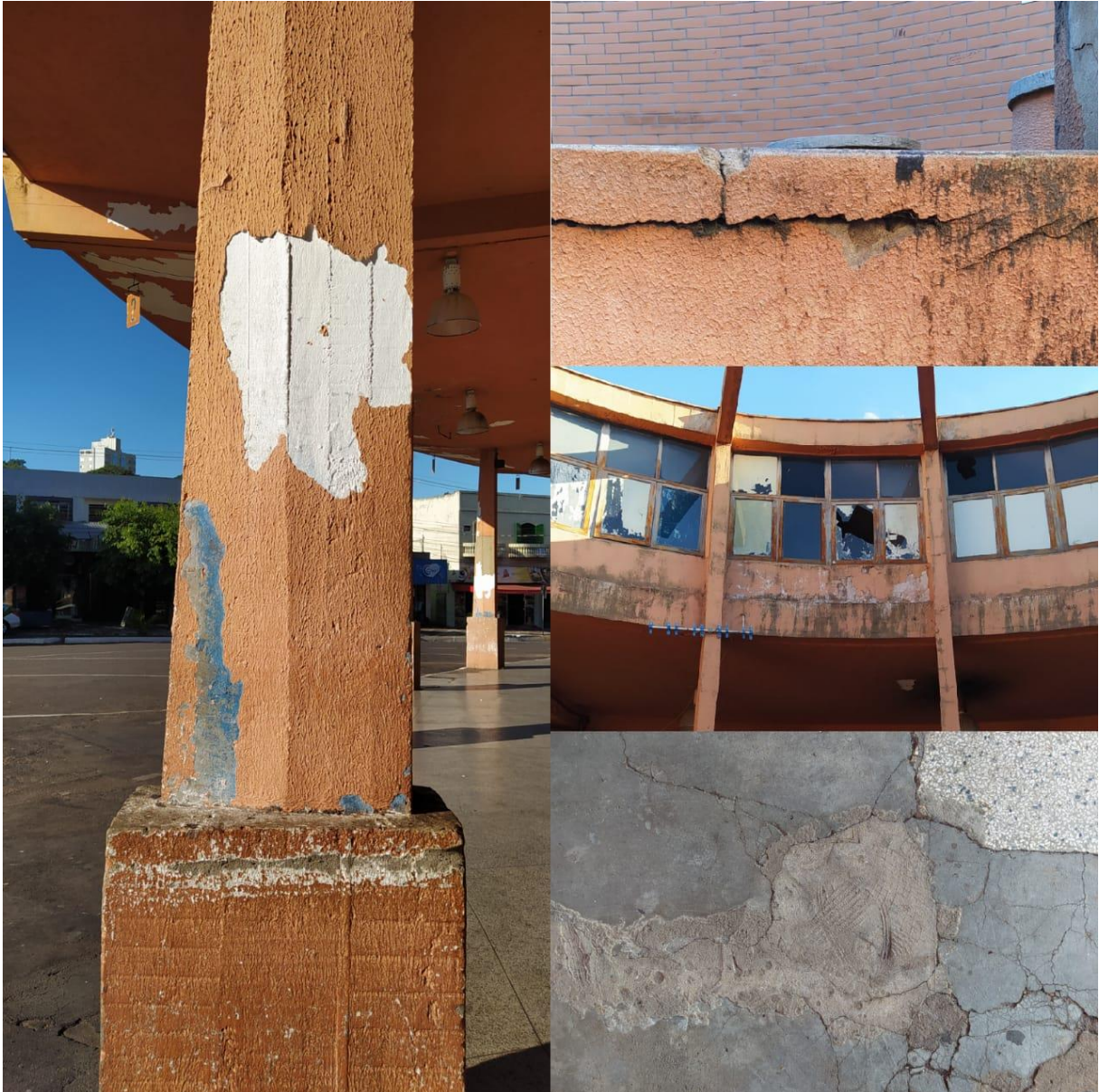
Figura 23 - Situação atual do edifício
