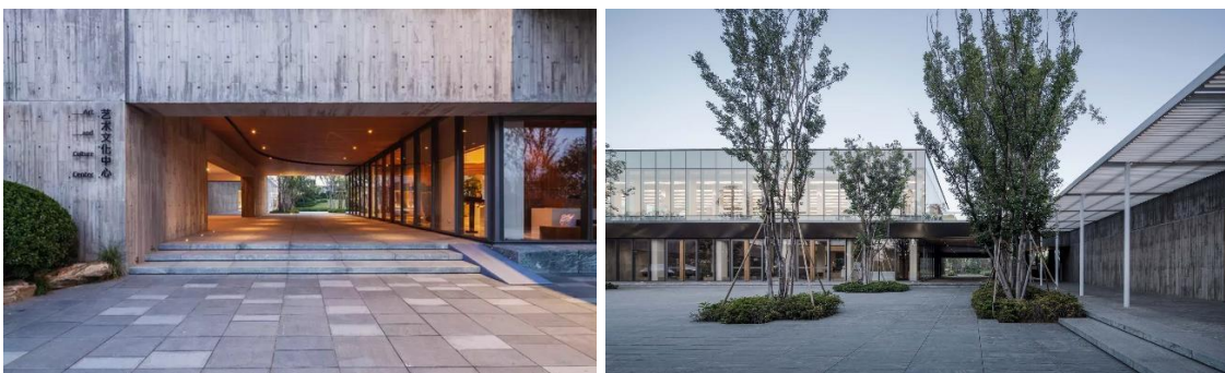
Figura 21 - visão do passeio para o interior do edifício (esquerda), visão interior do edifício para o passeio (direita)
