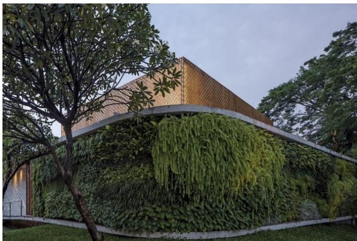
Figura 1 - Perspectiva da obra Aigai Spa
