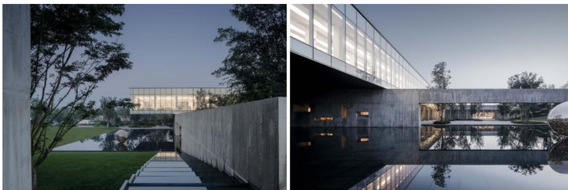
Figura 24 - Aberturas no edifício
