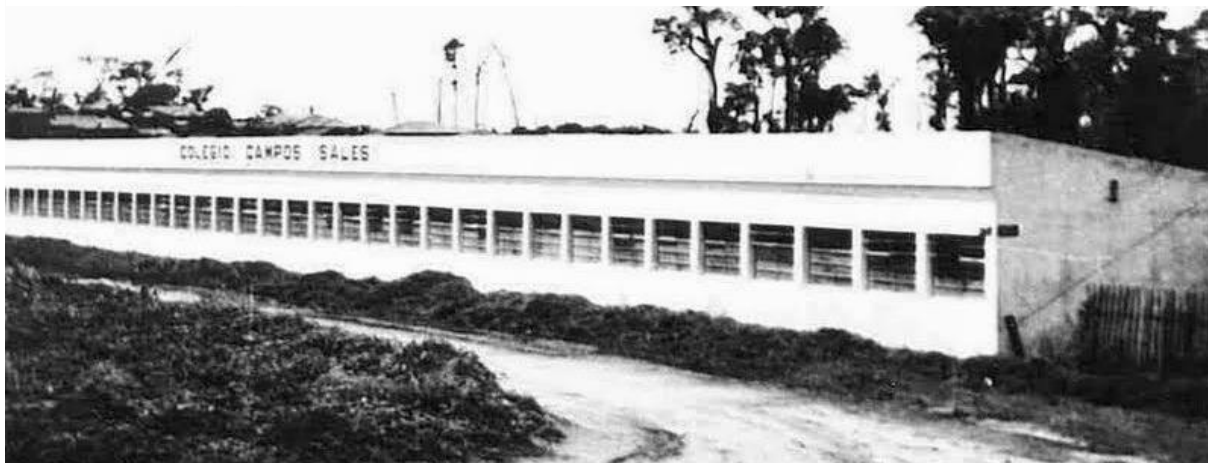
Figura 26 Perspectiva da fachada nordeste do Colégio Campos Sales em 1962
