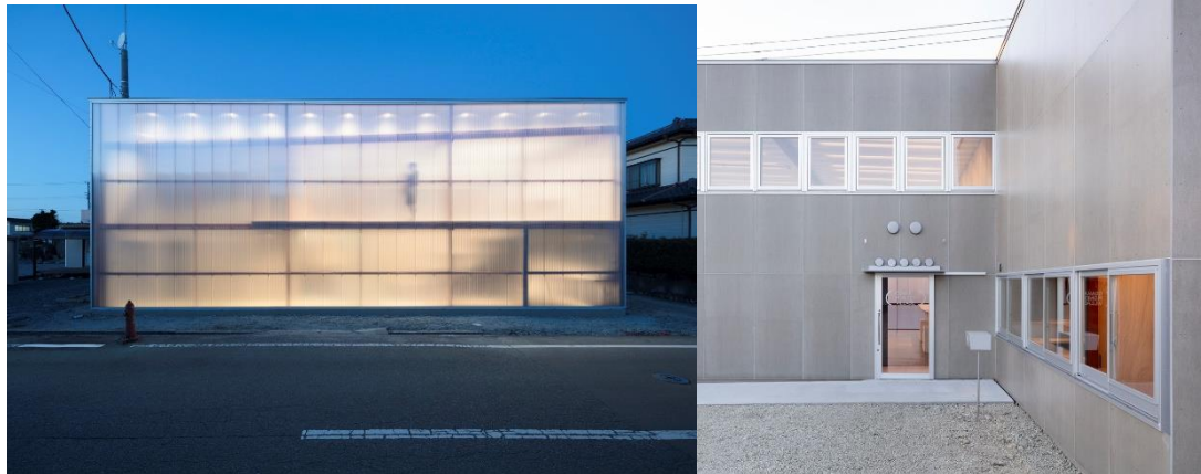
Figura 10 - Fachadas do edifício
