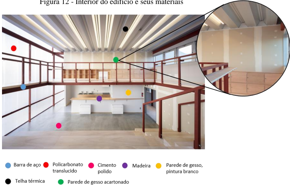
Figura 12 - Interior do edifício e seus materiais
