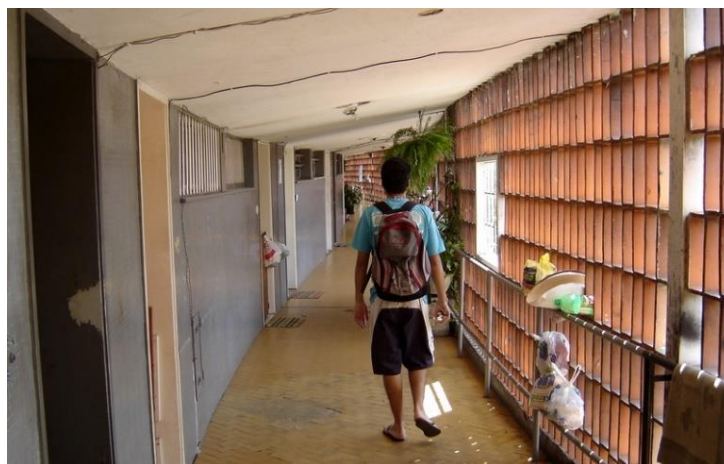
Figura 45 - Vista dos corredores com teto inclinado.
