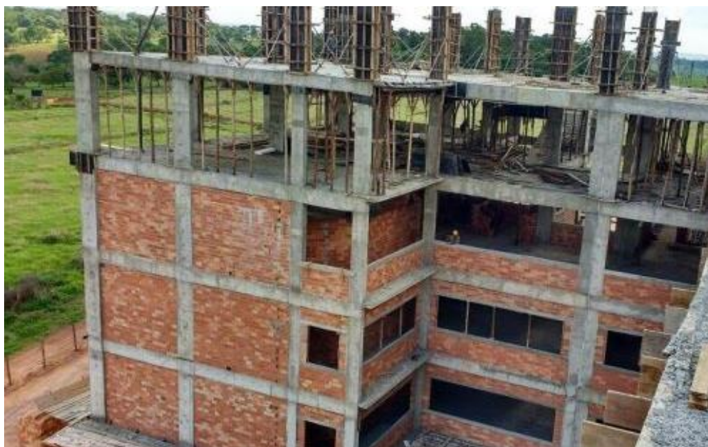
Figura 74 - - Construção de um edifício utilizando alvenaria de vedação em blocos cerâmicos e estrutura em concreto.
