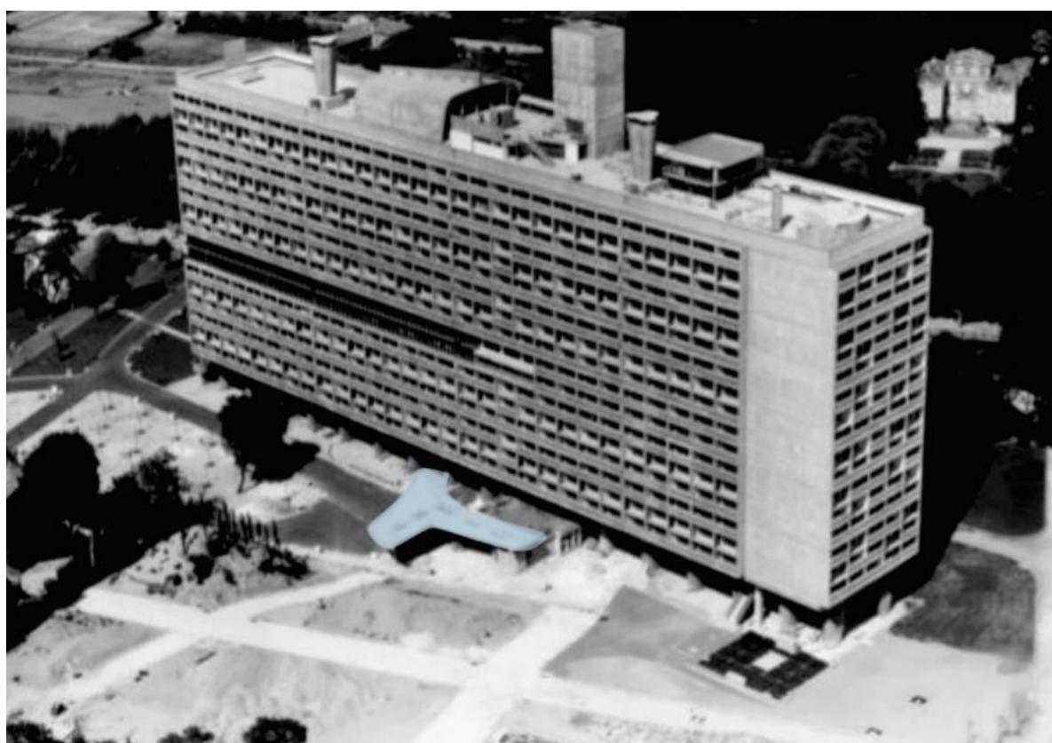
Figura 11 – Imagem do edifício destacando a cobertura do acesso.
