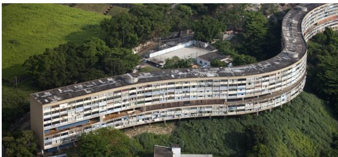
Figura 31 – Imagem do bloco A do Conjunto Pedregulho.
