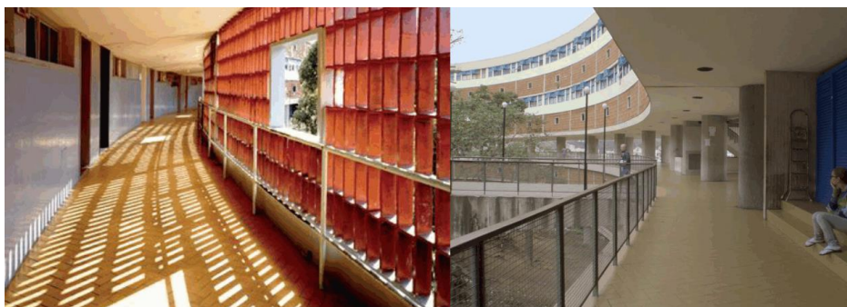
Figura 44 - Vista dos corredores.
