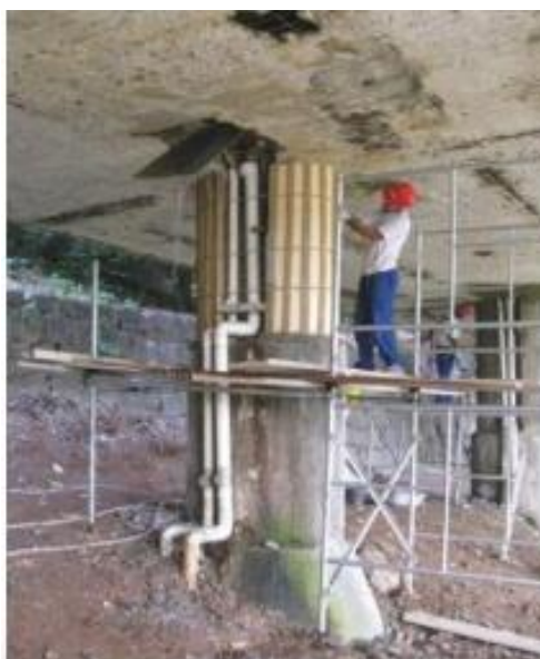
Figura 49 - Estrutura do pilar do edifício.
