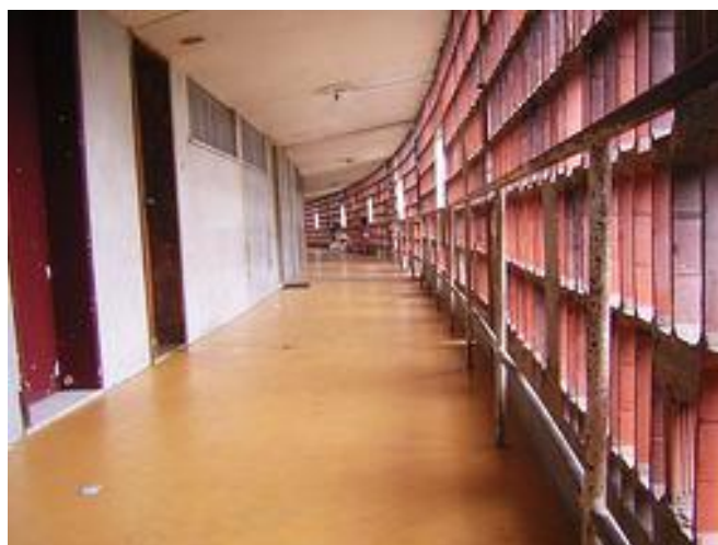
Figura 53 - Vista dos Corredores do bloco A.
