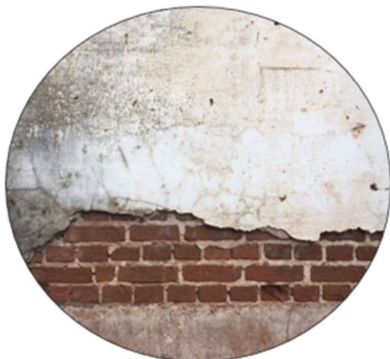
Parede lateral fachada Norte
