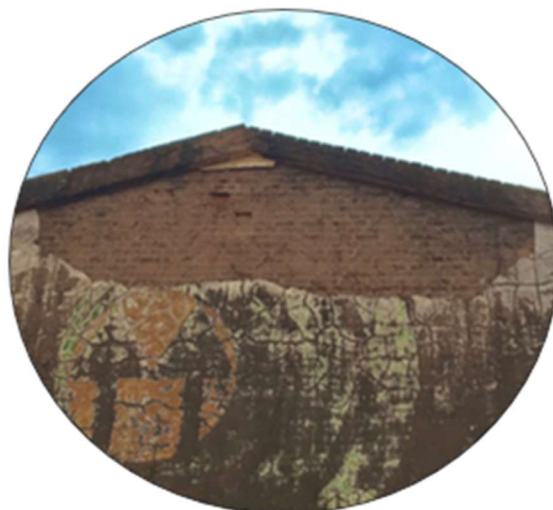
Topo da edificação fachada Sul
