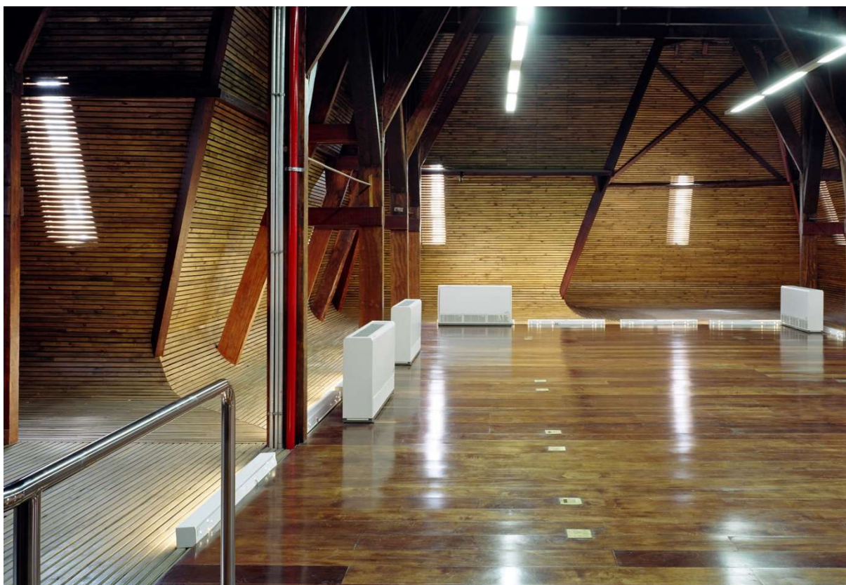
Figura 22 - Revestimento interno do sótão.
