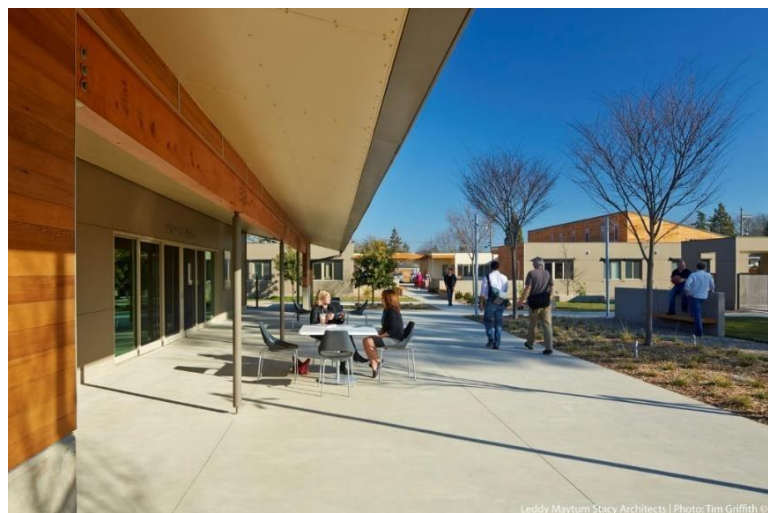
Figura 17 – Fachada lateral do Centro comunitário
