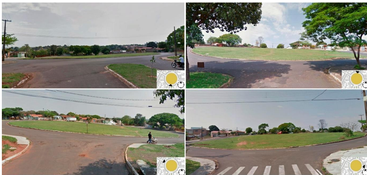
Figura 4114 - Vistas do terreno escolhido.
