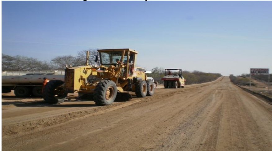
Figura 6: Execução da base.
