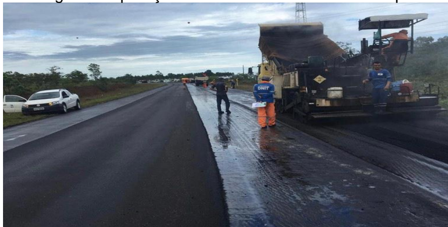
Figura 7: Aplicação do revestimento BR-156/Amapá.
