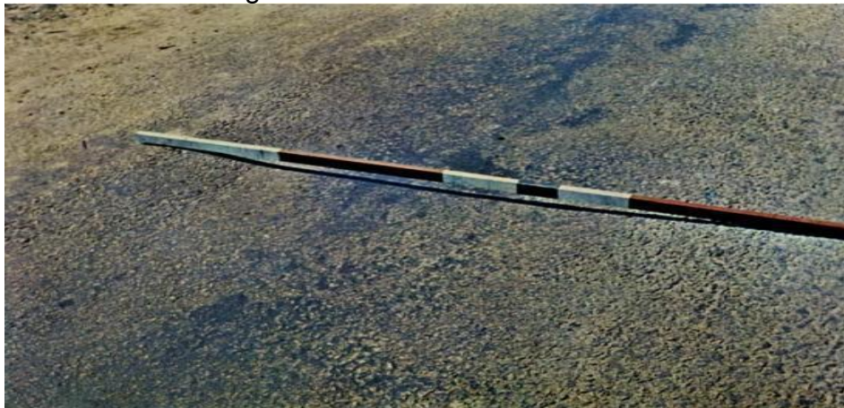
Figura 14: Afundamento local.
