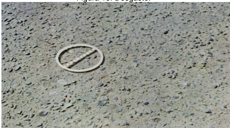
Figura 19: Desgaste.
