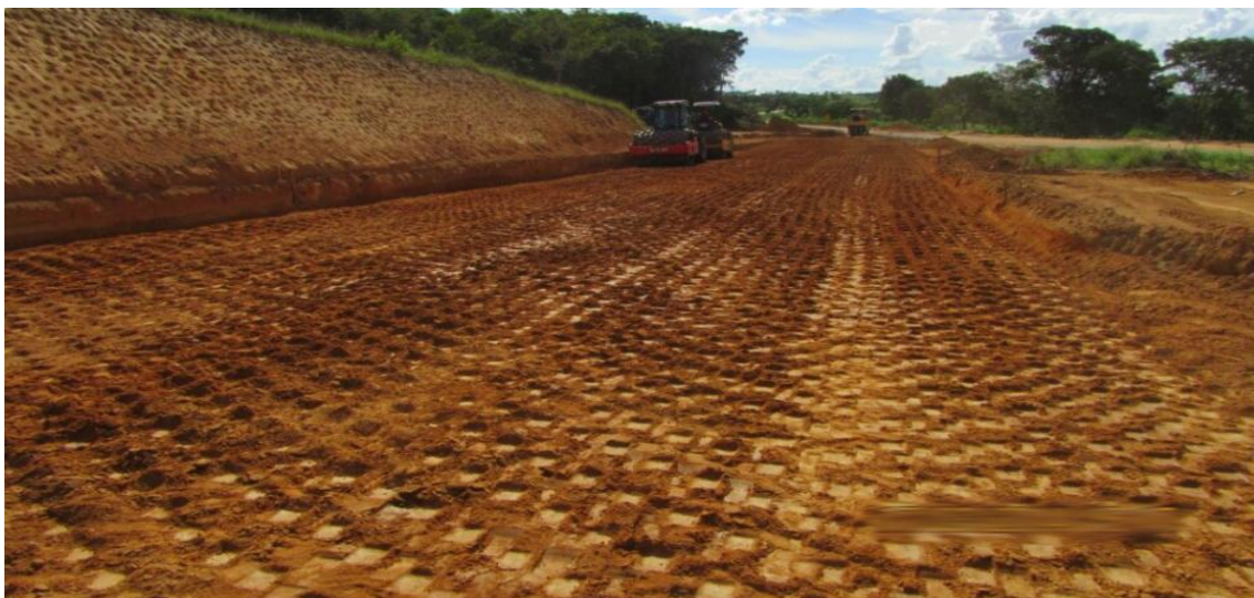
Figura 3: Compactação do subleito.
