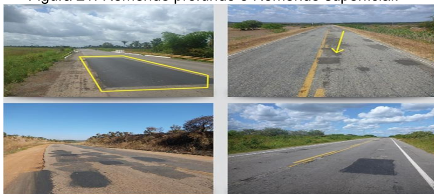
Figura 21: Remendo profundo e Remendo superficial.
