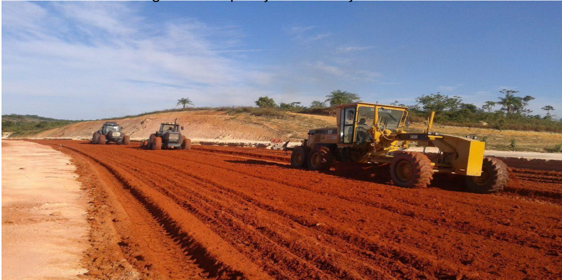
Figura 4: Preparação do reforço do subleito.
