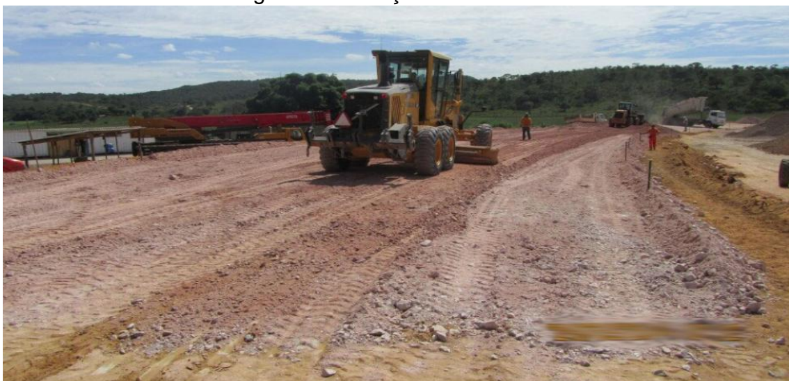
Figura 5: Execução da sub-base.
