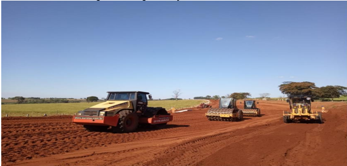
Figura 2: Regularização da BR-487/PR.
