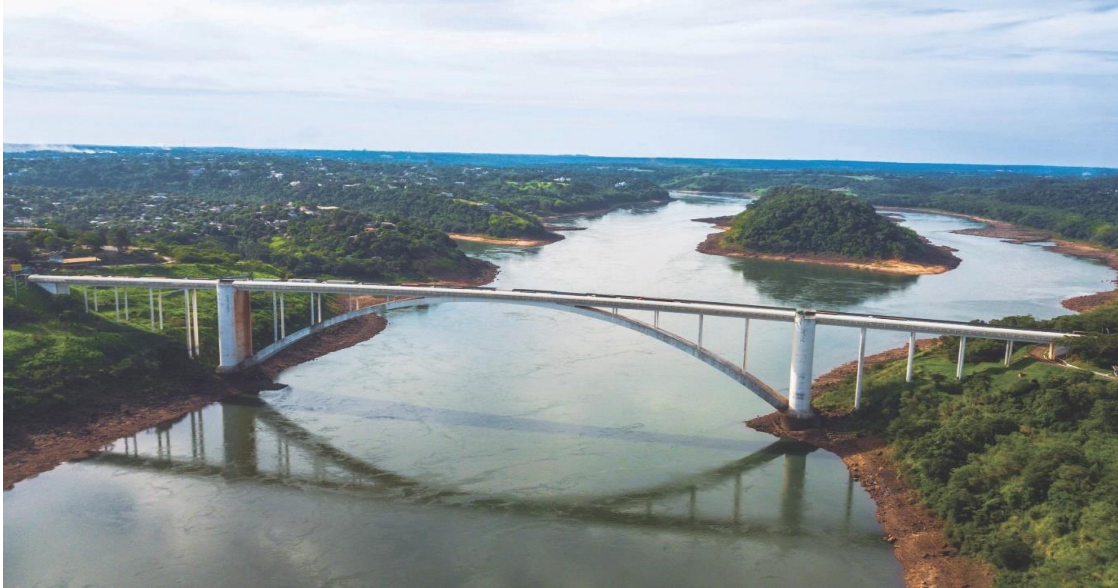
Figura 7: Ponte em arco. Ponte da Amizade.
