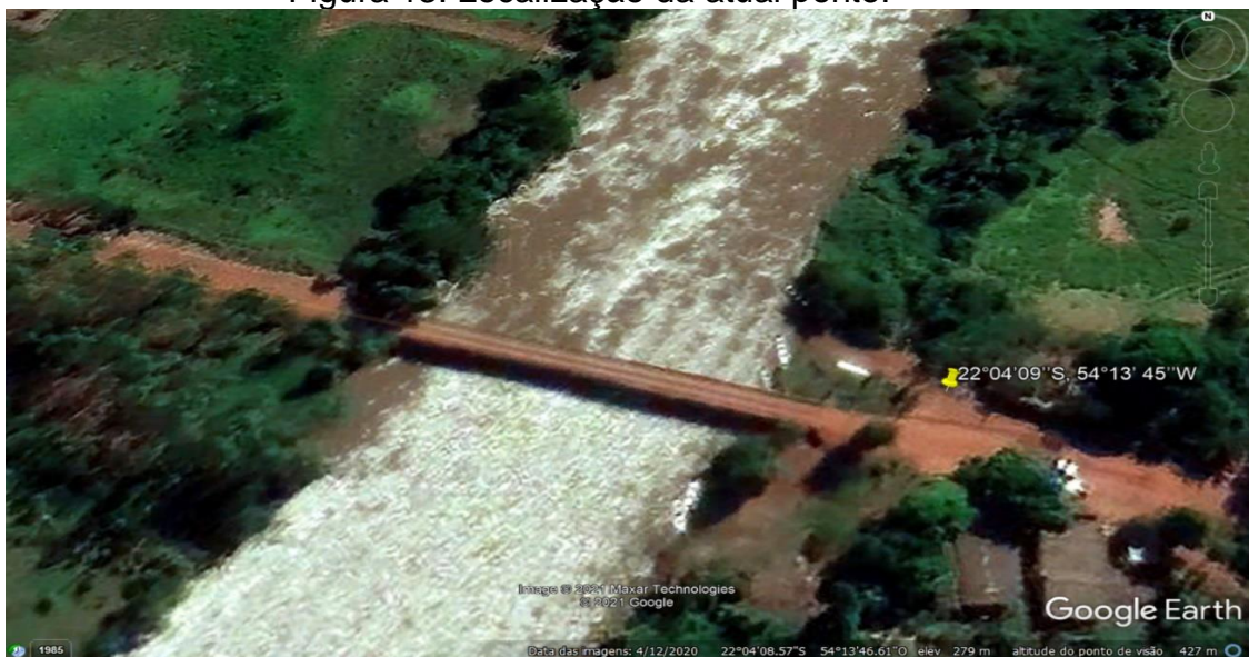
Figura 13: Localização da atual ponte.
