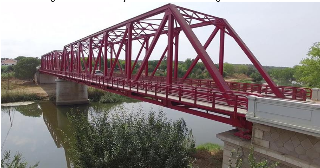
Figura 5: Ponte treliçada. Ponte Santa Margarida do Sado.
