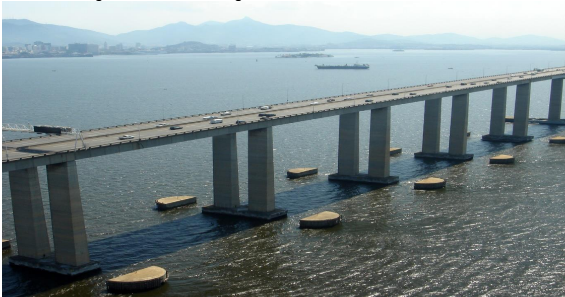
Figura 4: Ponte em viga. Ponte Presidente Costa e Silva.
