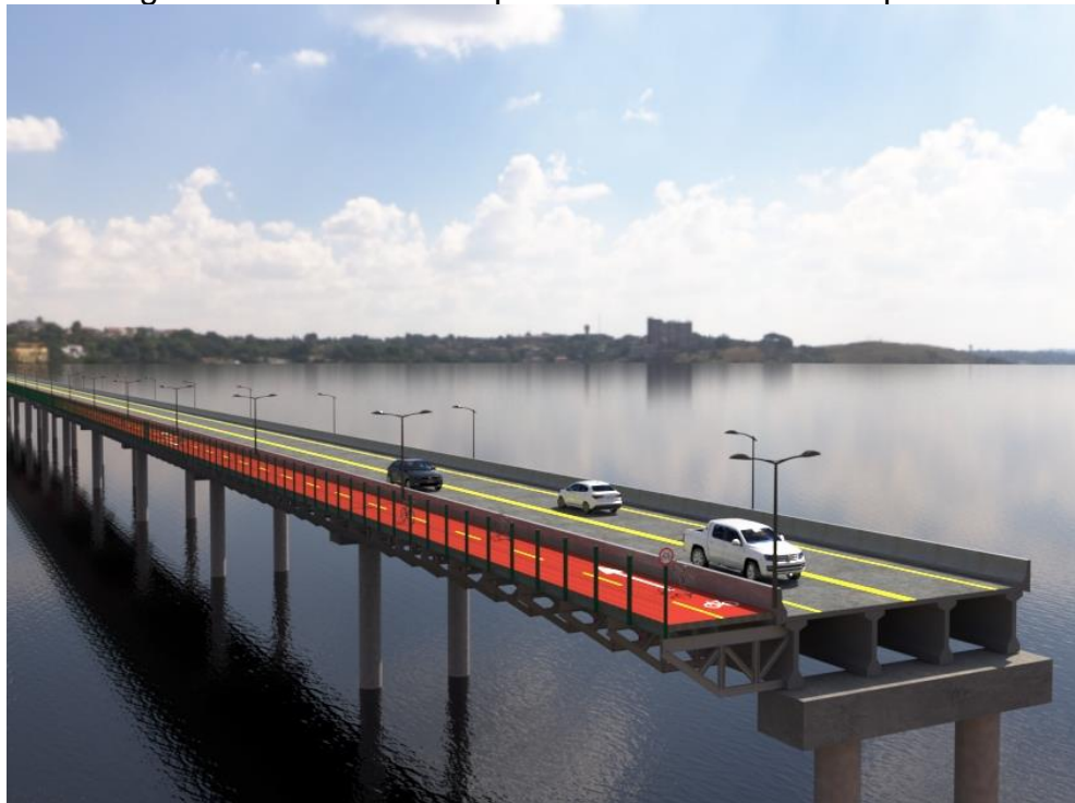
Figura 22: Ciclovia acompanhando a estrutura da ponte.
