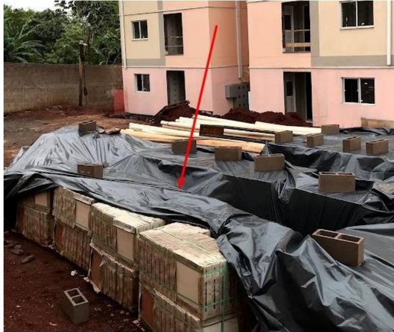
Figura 17: Pisos cerâmicos armazenados no canteiro de obra. Data 29/10/2020.
