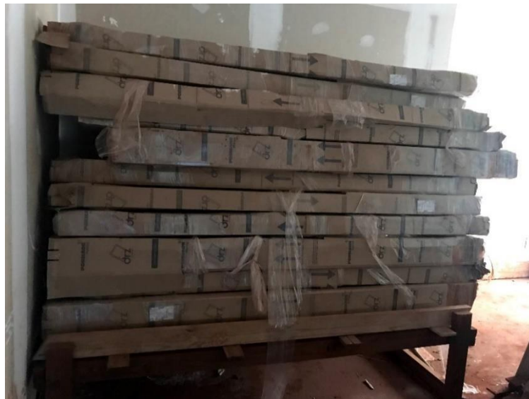
Figura 23: Esquadrias de madeira armazenadas no canteiro de obra. Data: 17/05/2021
