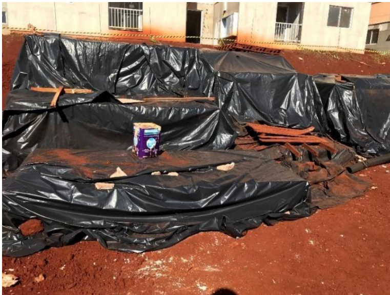
Figura 09: Placas de gesso armazenadas no canteiro de obra. Data 07/07/2021
