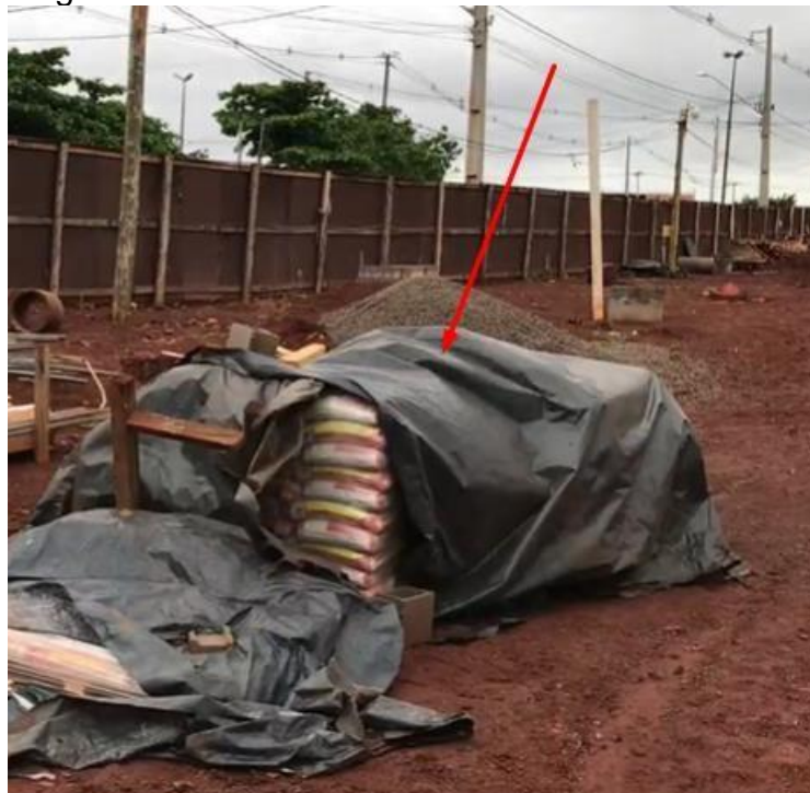
Figura 14: Argamassas armazenadas no canteiro de obra. 29.10.2020
