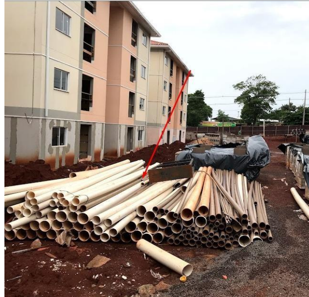
Figura 20: Tubos de policloreto de vinila armazenados no canteiro de obra. Data:29/10/2020
