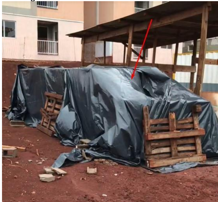
Figura 05: Placas de gesso armazenadas no canteiro de obra. Data: 29/10/2020
