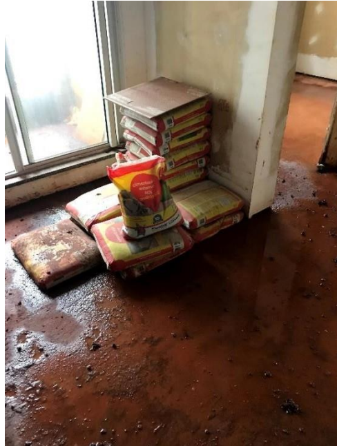
Figura 15: Argamassas armazenadas no interior dos apartamentos. Data:15/01/2021
