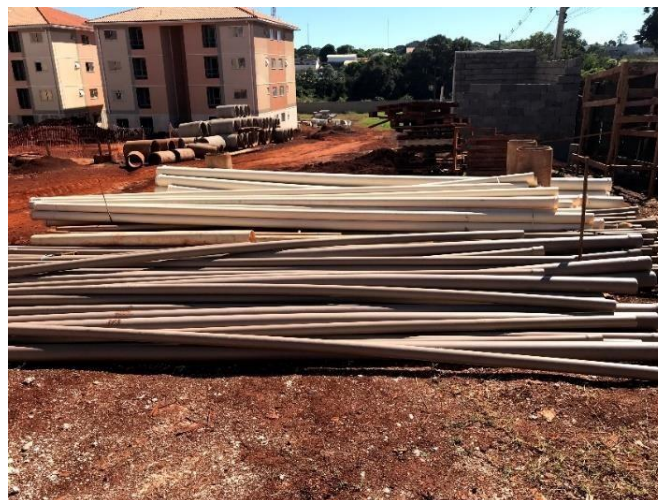
Figura 21: Tubos de policloreto de vinila armazenados no canteiro de obra. Data:24/04/2021
