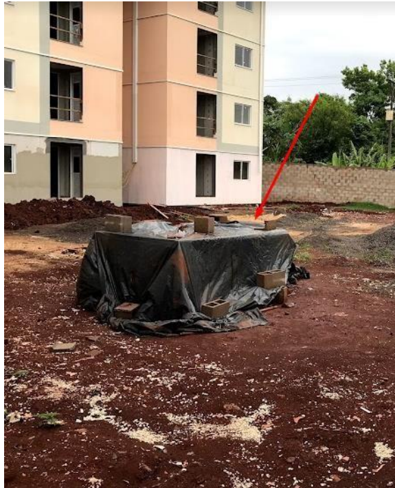
Figura 09: Placas de gesso armazenadas no canteiro de obra. Data: 29/10/2020
