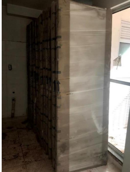
Figura 22: Esquadrias de madeira armazenadas no canteiro de obra. Data: 30/04/2021
