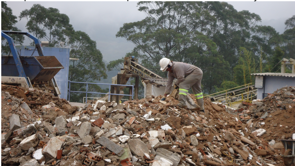
Figura 4: Operário verificando e separando resíduos de construção e demolição
