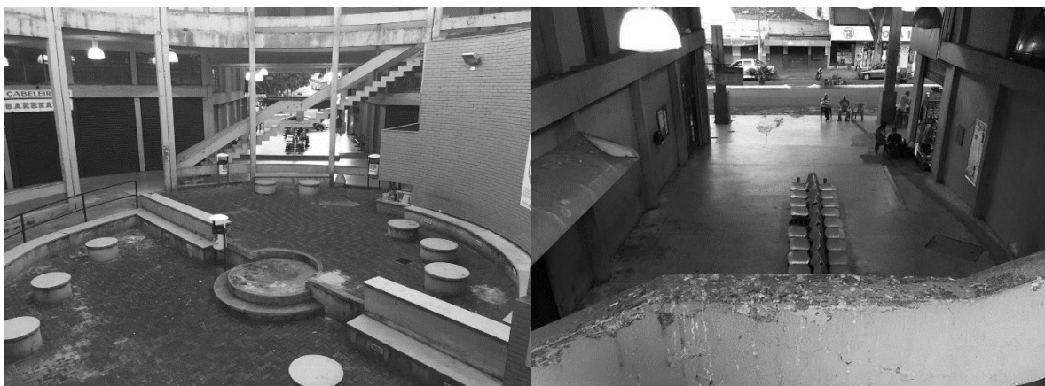
Figura 53 – Pátio central e área de estar entre blocos de boxes da rodoviária municipal de Umuarama.
