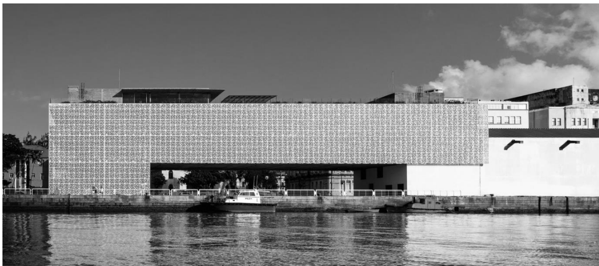
Figura 32 – Vista do projeto Museu Cais do Sertão , face voltada para o mar.
