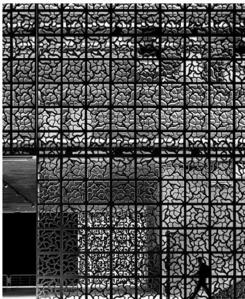
Figura 33 – Fechamentos em Cobogó que compõem as faces abrangentes do centro cultural Museu Cais do Sertão .
