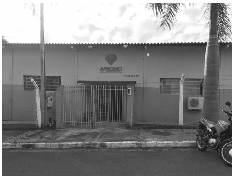
Figura 41 – Acesso principal do bloco de serviços.
