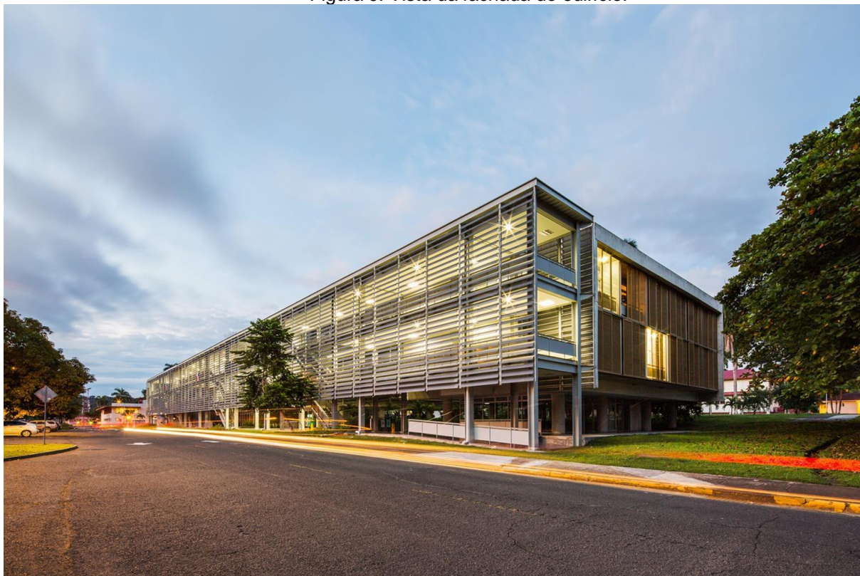
Figura 5. Vista da fachada do edifício.
