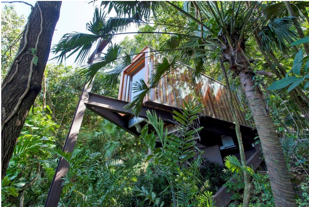
Figura 34 – Capela do Joá – Vista externa.
