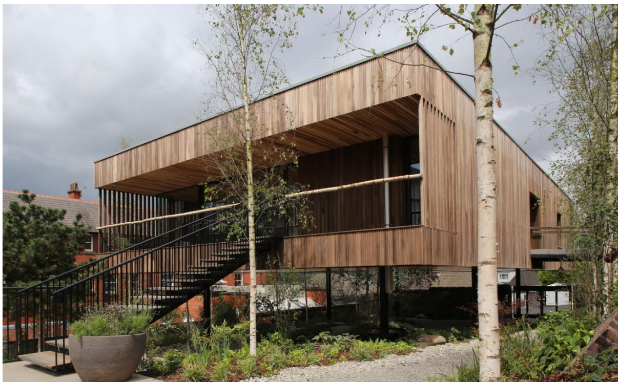
Figura 10 – Vista frontal do Centro Maggie.
