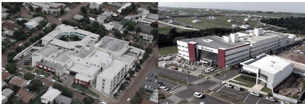
Figura 19 – Vista aérea da unidade de Cascavel-PR e Umuarama-PR, respectivamente.
