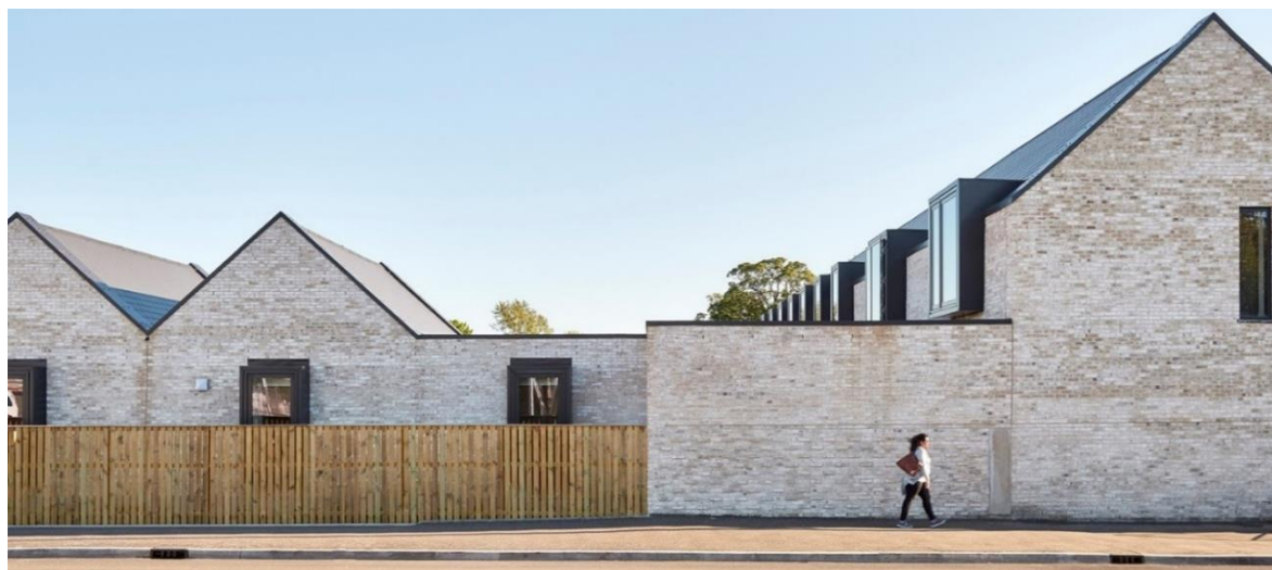
Figura 08 – Fachada frontal da Ronald McDonald House .
