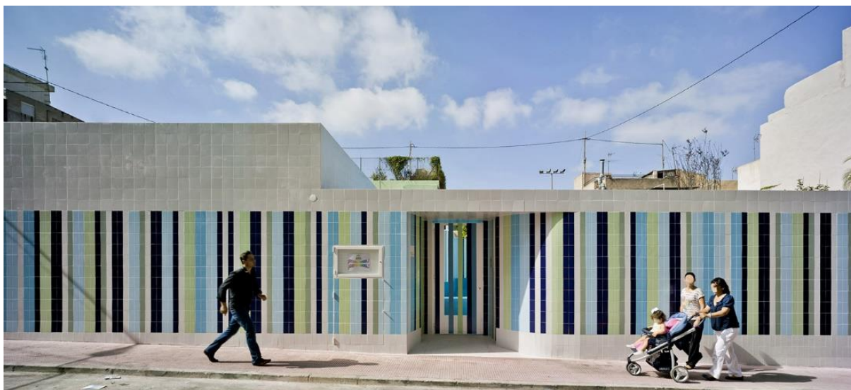
Figura 09: O jardim das silhuetas, vista da parte exterior.
