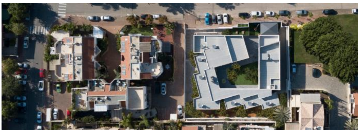
Figura 11 - Vista superior da edificação
