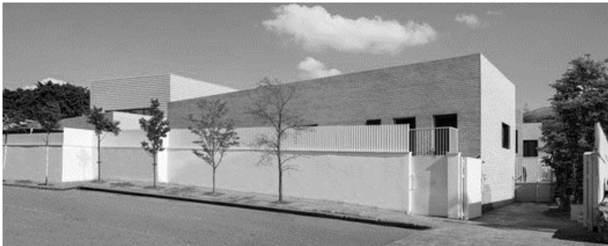
Figura 8 – Fachada externa da edificação
