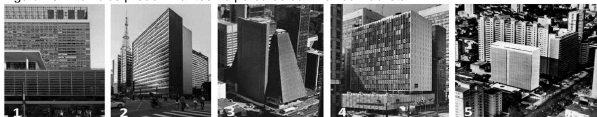
Figura 25 - Edifícios predominantes no percurso da Avenida Paulista
