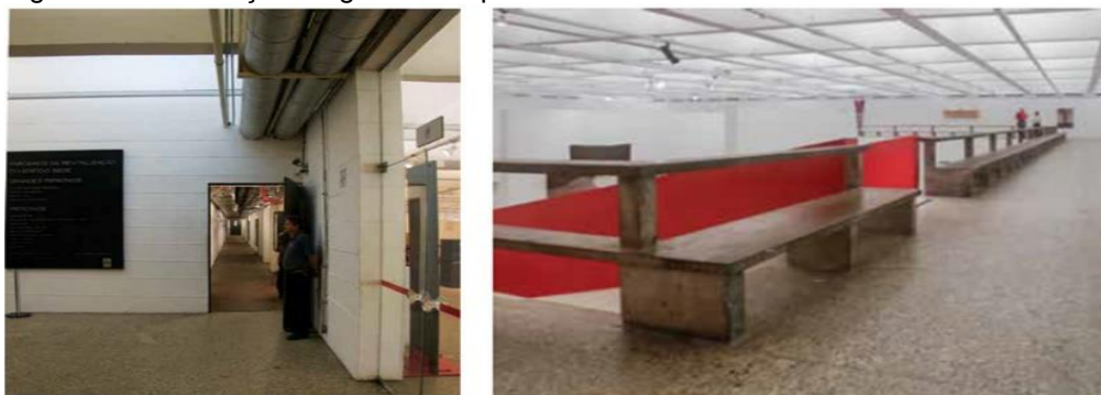
Figura 37 - Tubulações e guarda-corpo Museu da Arte de São Paulo
