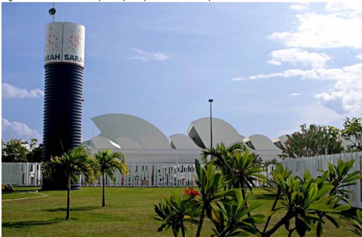
Figura 16- Sheds maiores quadra poliesportiva e hidroterapia.
