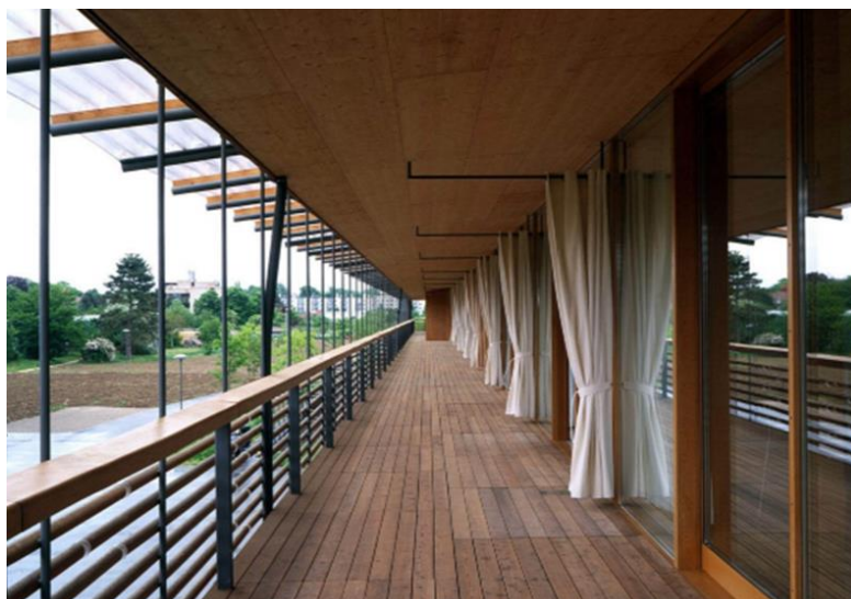
Figura 11- Varandas e brises entre ambientes internos e externos.
