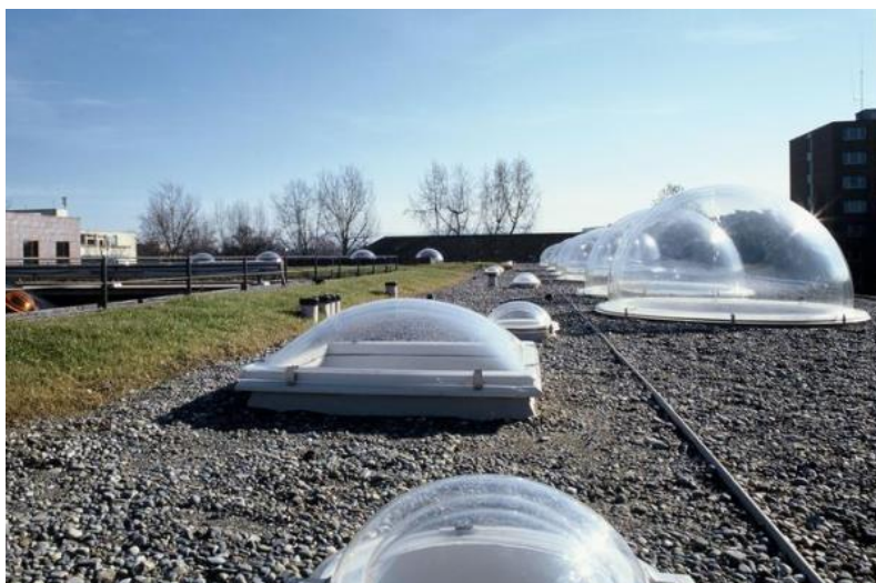
Figura 10- Claraboias de iluminação externa e internamente
