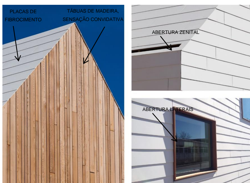
Figura 28 - Detalhes da aparência dos materiais.
