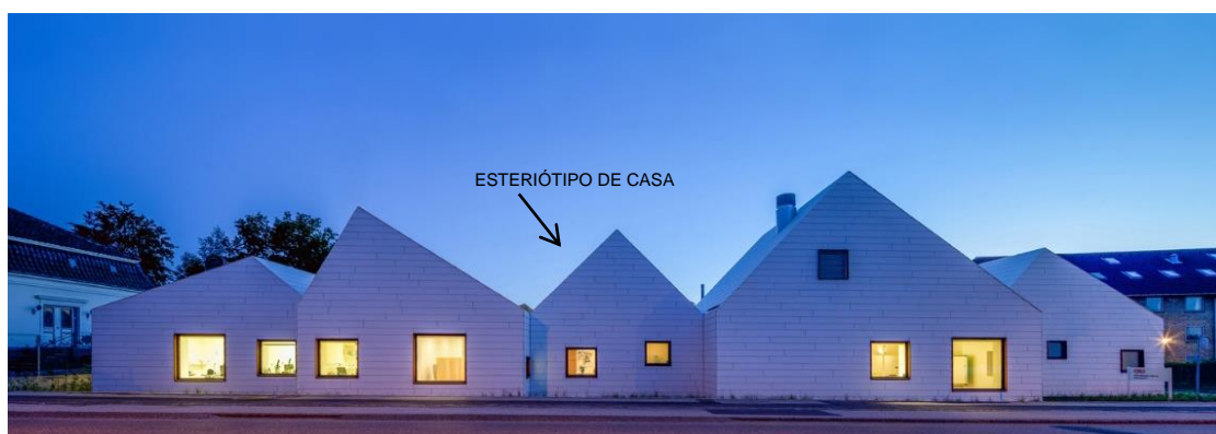
Figura 27 - Elevação posterior na via de maior movimento.
