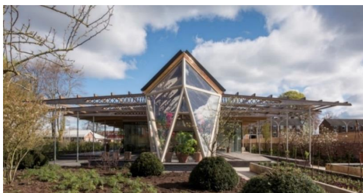
Figura 2 - Vista externa do Centro de Tratamento
