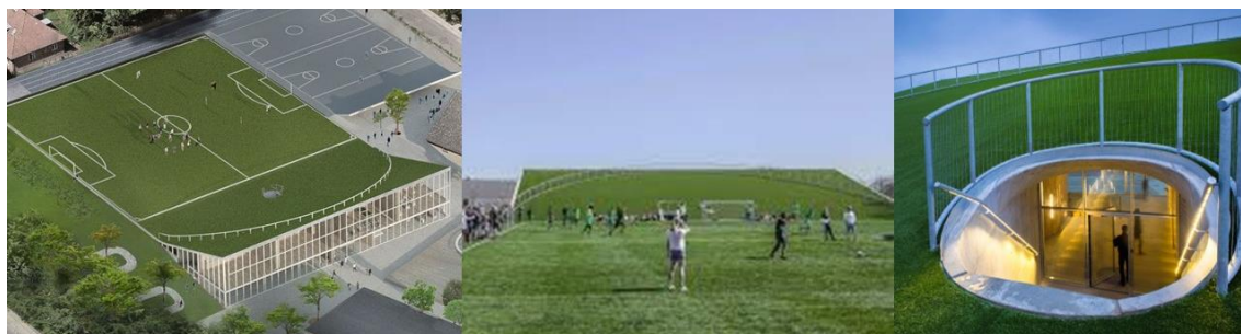
Figura 12 – cobertura verde no pavilhão de arte e cultura
