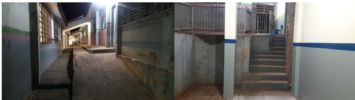
Figura 27 – circulações entre os pavilhões de sala de aula
