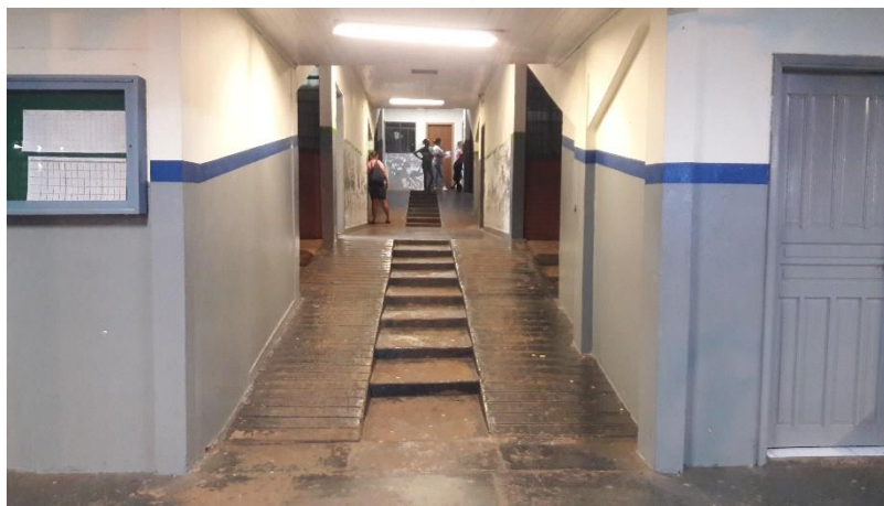
Figura 26 – corredor de acesso às salas de aula
