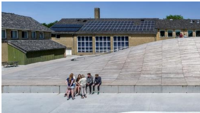
Figura 9 – painéis para a captação de luz solar
