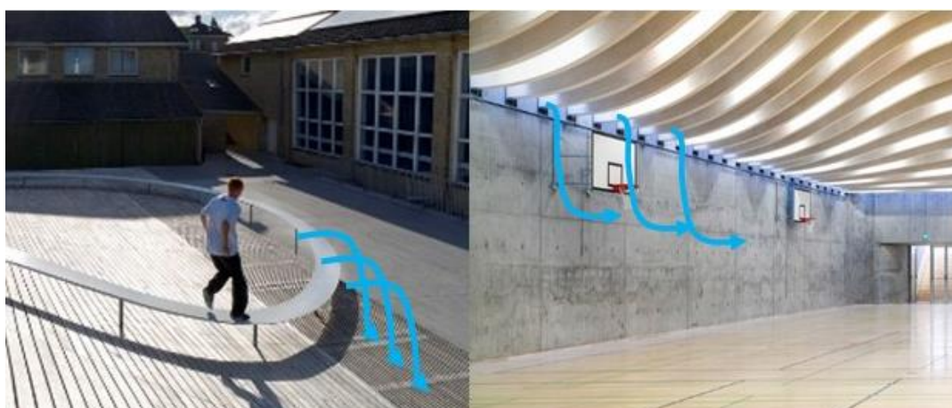
Figura 10 – janelas para captação de iluminação natural
