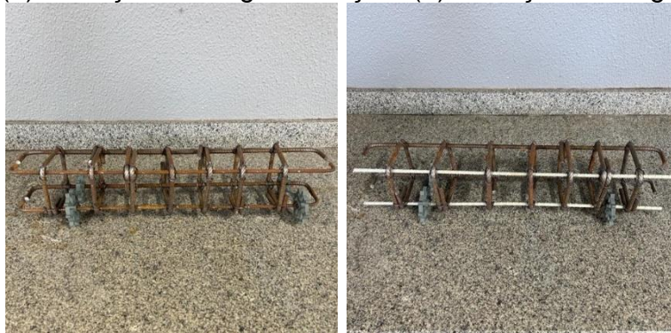
Figura 07: (a) Armação das vigas de Aço e (b) Armação das vigas de PRFV
