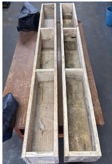
Figura 12: Caixarias utilizadas como molde para as vigas
