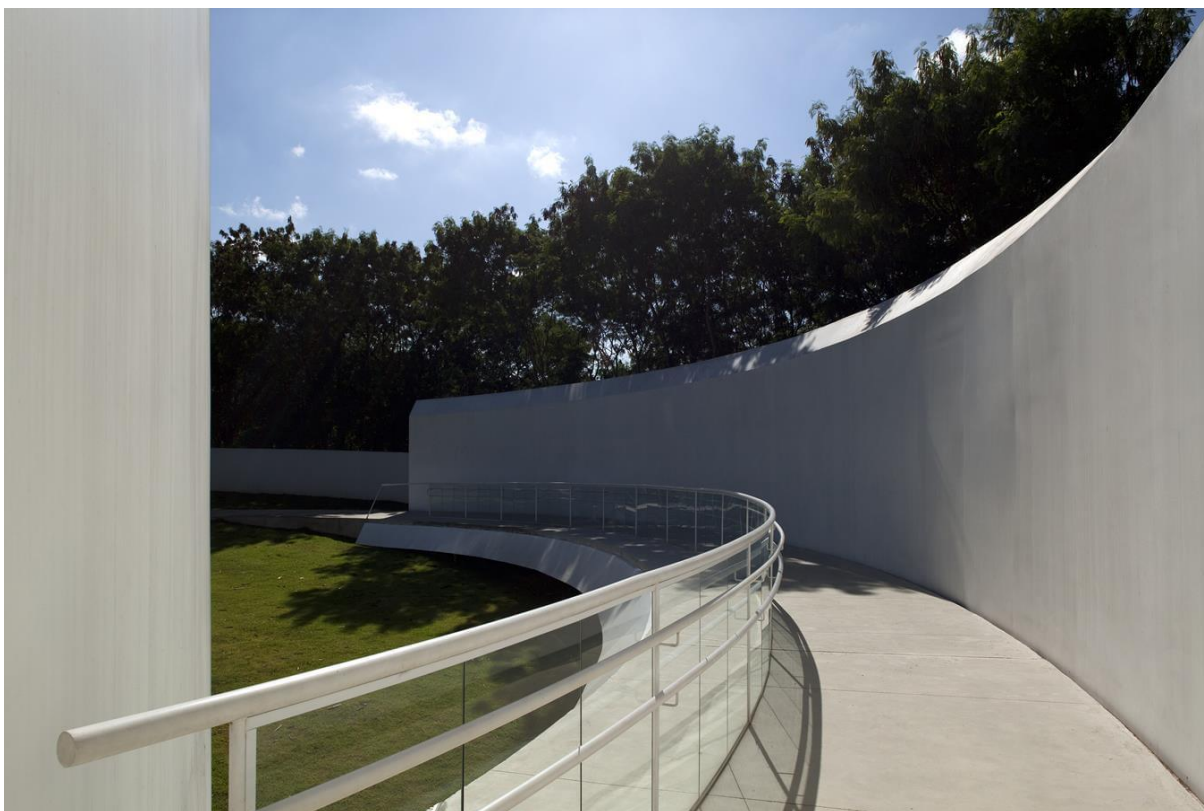
Figura 18 - Estrutura e pintura
